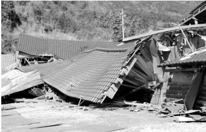
輪島市内の各所で民家が崩壊しています
